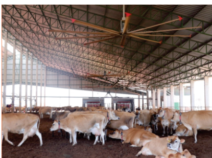
Cama de compostagem com ventilação
