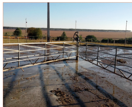
Sala de espera com aspersão
